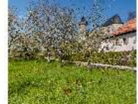
SaZwe.I, Fassade von Süd-Osten, DI007816, BSV-
