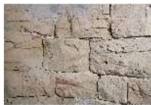
SaZwe.I, Mauerwerk im Bergfried (Detail), DI008221, BSV-
