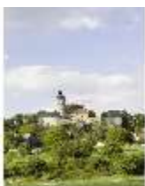
SaZwe.I, Burgfassade, Blick von Süden, DI008239, BSV-
