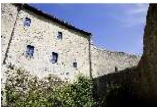
SaZwe.I, Blick vom Kapellenhof auf die Fassade, DI008230, BSV-
