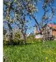
SaZwe.I, Fassade von Süd-Osten, DI007815, BSV-
