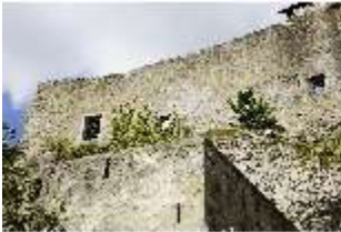
SaZwe.I, Blick auf die Wehrmauer vom Schönhof, DI008231, BSV-
