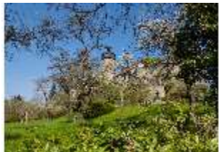
SaZwe.I, Fassade von Süd-Osten, DI007813, BSV-
