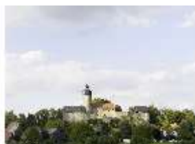
SaZwe.I, Burgfassade, Blick von Süden, DI008240, BSV-
